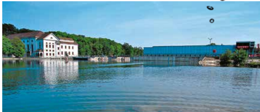
Verstärkung für mehr Leistung: Um den laufend steigenden Strombedarf decken zu können, wurde bereits im Jahr 1925 das zweite Kraftwerk, Schwarzhäusern, mit vier Propellerturbinen gebaut.
